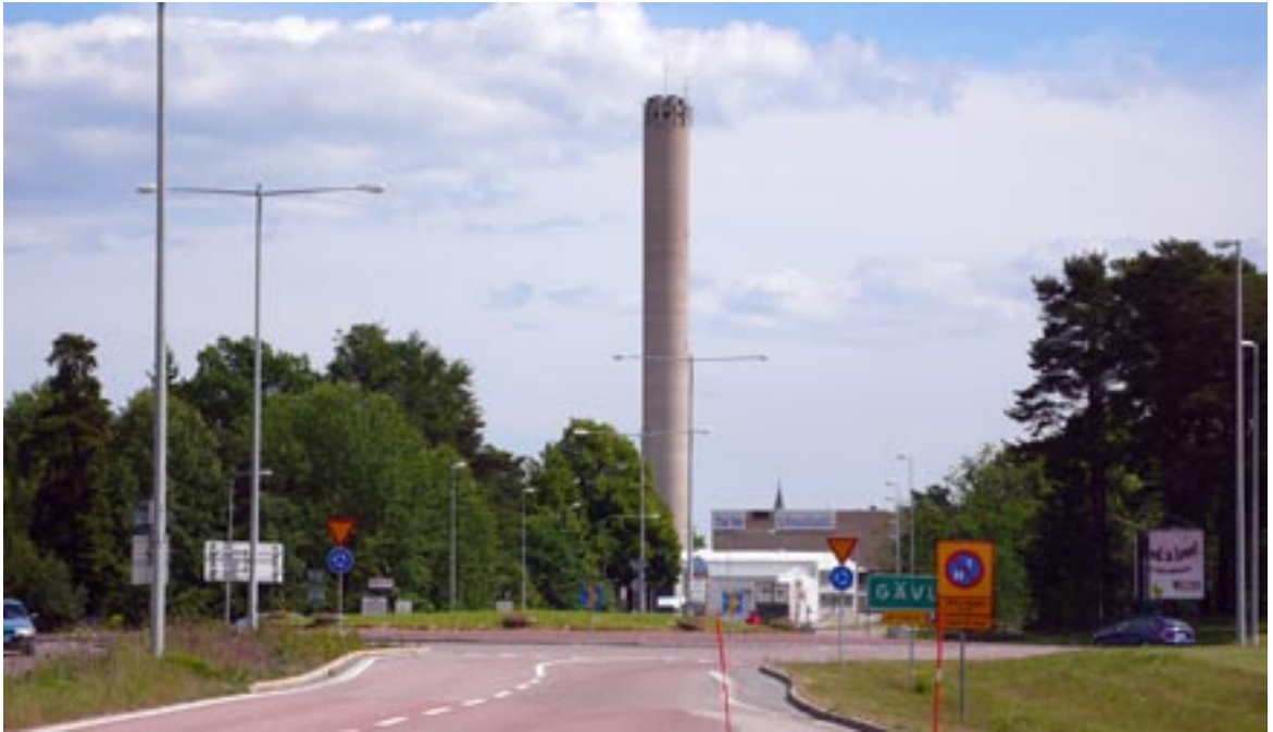
Vy över Trafikplats Gustavsbro innan ombyggnationen
